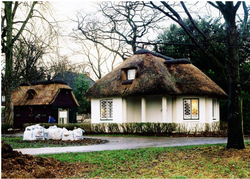
Foto des Pförtnerhäuschens
