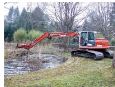
Ein Bagger übernimmt die schwereren Arbeiten
