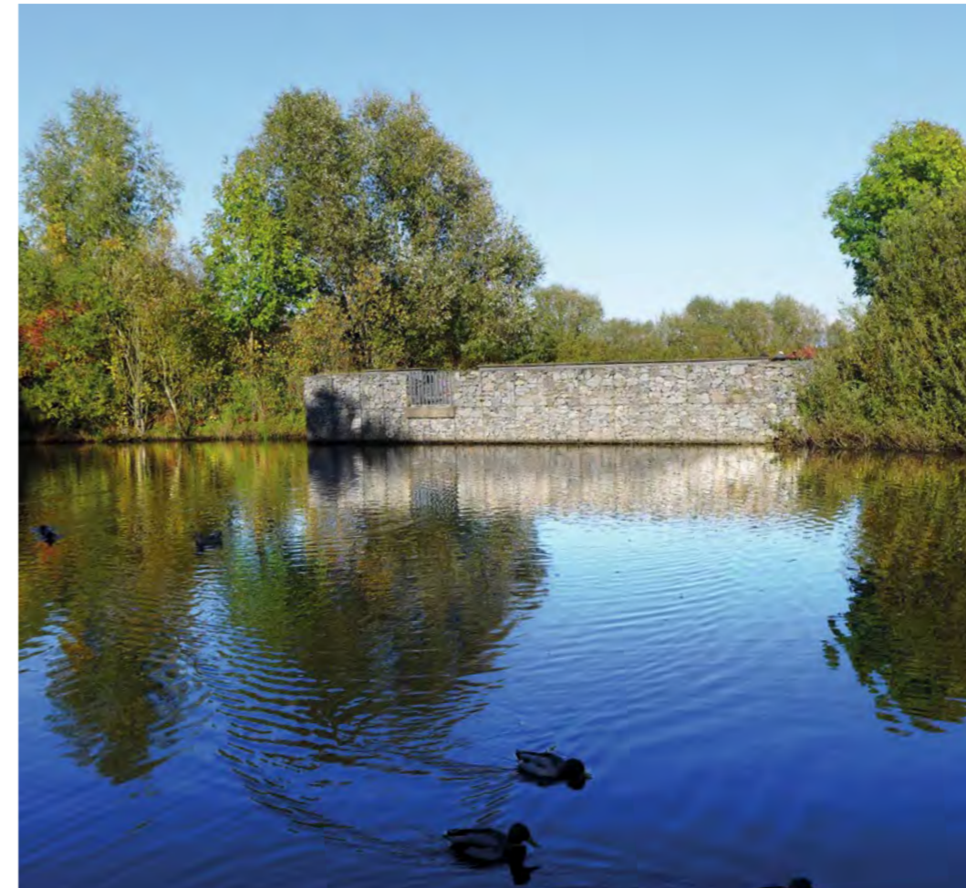
◀ Absetzbecken mit Damm vor dem Kätcheslachweiher (dahinter).
