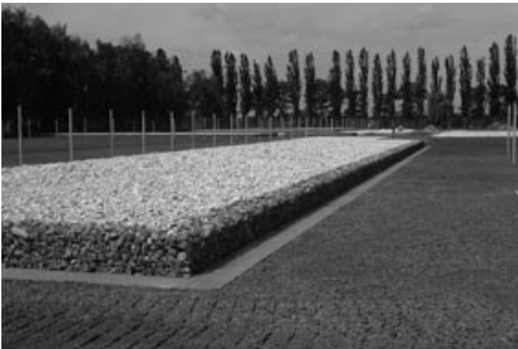
Gabionen markieren die Standorte der ehemaligen Gebäude
